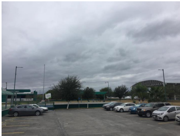
Colocación de iluminaria en el área de estacionamiento.
